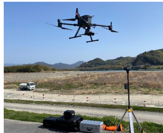
UAV による3次元測量状況
