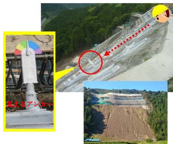
図 2-29：見えるアンカーの現場での適用例（出典：調査団作成）
