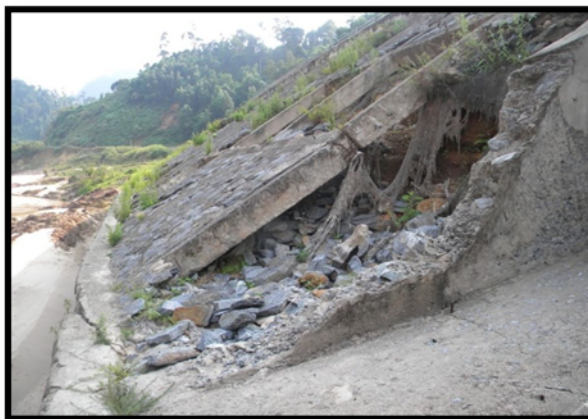
図 1-5：再発事例（法枠、排水工） （出典：ベトナム道路総局セミナーレポート 2015 年 4 月）
