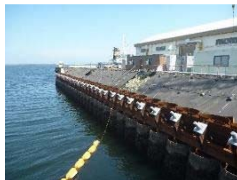
既設港湾岸壁の補強事例
