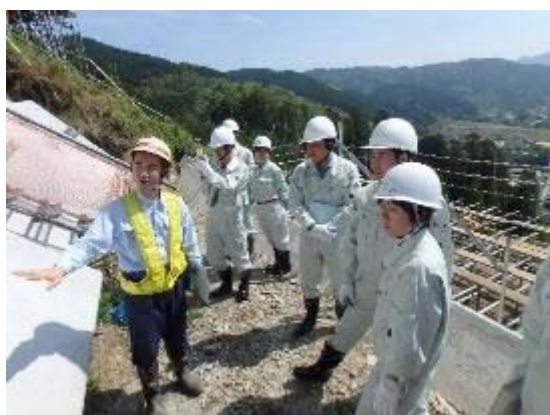
施工現場の解説の様子
