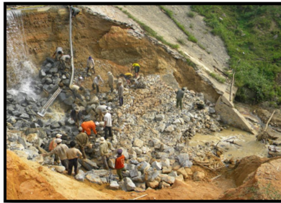
図 1-5：再発事例（法枠、排水工） （出典：ベトナム道路総局セミナーレポート 2015 年 4 月）
