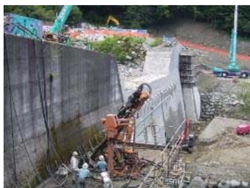
砂防堰堤の補強事例
