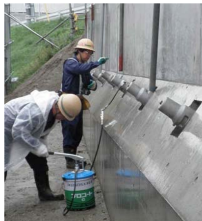
図 2-27：防食材料の注入例 (出典：調査団撮影)
