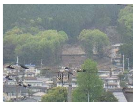
広島土砂災害の現場視察(2)
