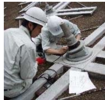
図 2-16：供用期間中の維持管理の例 （出展：調査団撮影）
