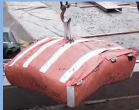
内部拘束式箱型土のう D-Box
