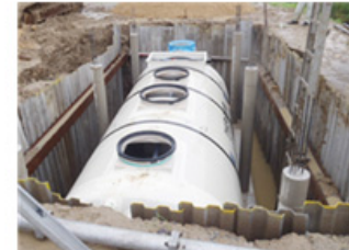
浄化槽の設置工事
