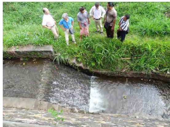
Site 7 現地調査
