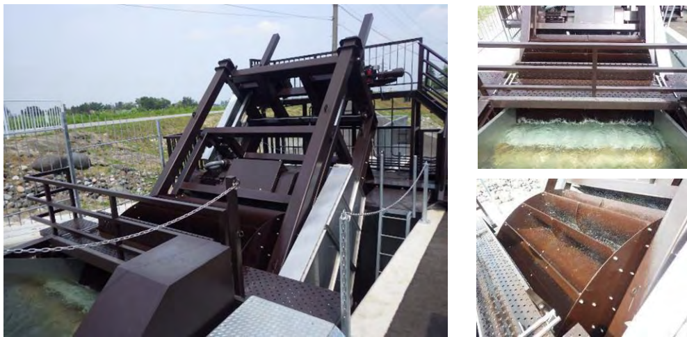
写真 2-2 導入実績(富山県富山市内 常西用水土地改良区西番小水力発電施設 : 可動式開放型胸掛け式水車)
