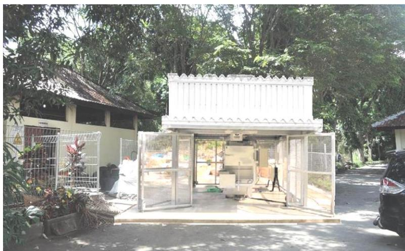
小型焼却炉「チリメーサー」設置イメージ図 (写真: ㈱トマス技術研究所提供)
