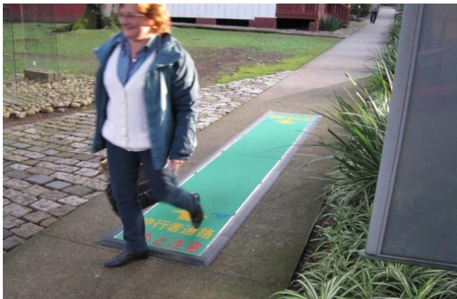
① ブラジル国クリチバ市「発電床」仮設置場(屋外)
