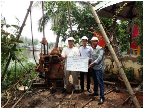
ホーチミン市での土質調査
