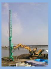
MITS工法CMSシステム (小型・中圧噴射機械攪拌工法)
