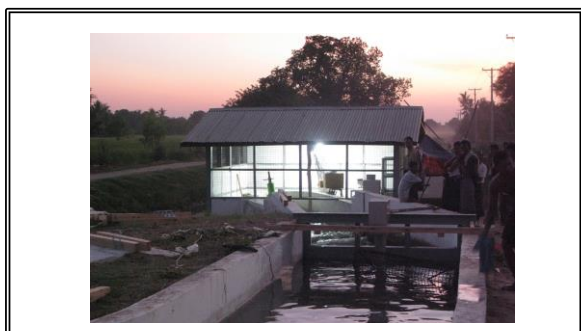
蓄電式ハイブリッド発電機(ミャンマー国マンダレー) (写真提供:株式会社日建)
