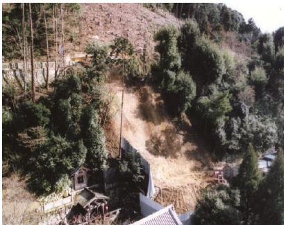
清水寺「音羽の滝」に隣接する斜面が豪雨により崩壊
