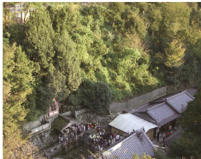
ジオファイバー工法で斜面を保護し、植生工によって自然景観が回復
