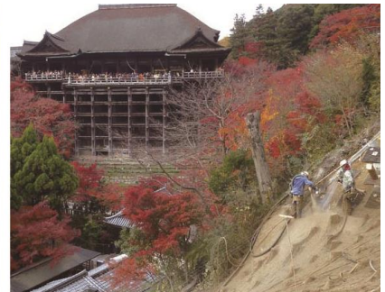
対策済の隣接斜面が豪雨で崩壊し、ジオファイバー工法で復旧
