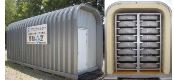
自然氷の冷熱を利用した低温貯蔵庫・アイスシェルター
