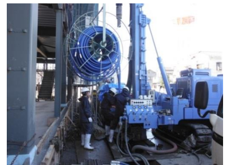
写真上：地中に掘削された垂直孔に筒を挿入する様子
