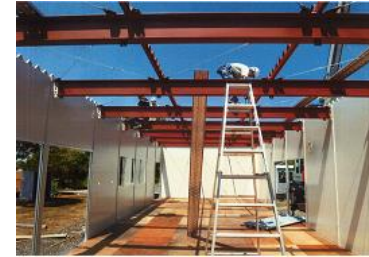
プレハブ・システム建築工法による施工風景
