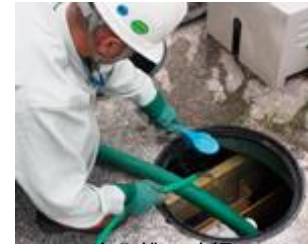
浄化槽の清掃
