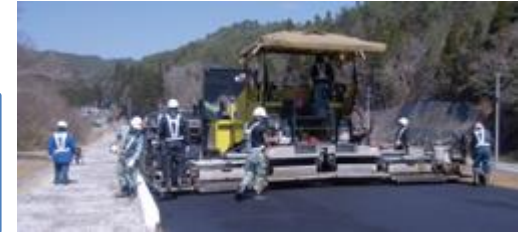
再生アスファルトを活用した舗装
