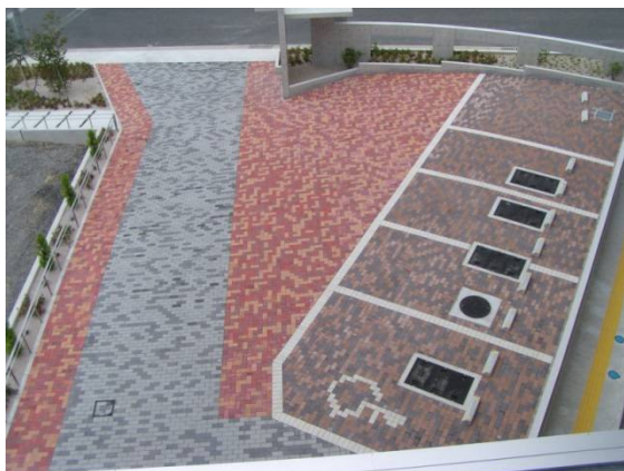
（左）インターロッキングブロック（ILB）施工例 “水たまりが出来ず、雨が降っても滑らない”
