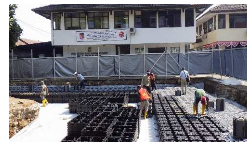
プラスチック製雨水貯留構造体の施工状況
