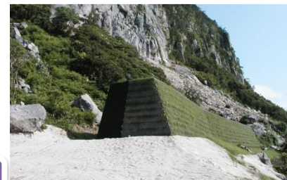
提案製品の日本国内施工事例
