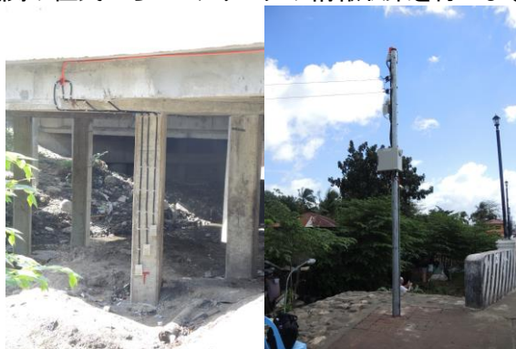
河川敷に設置の同社の検知センサー(左)と警報装置(右)(フィリピン)
