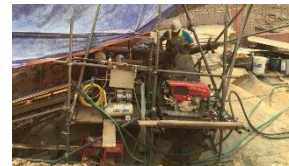
ハイブリッド工法による ダムサイト地質調査(斜掘り)
