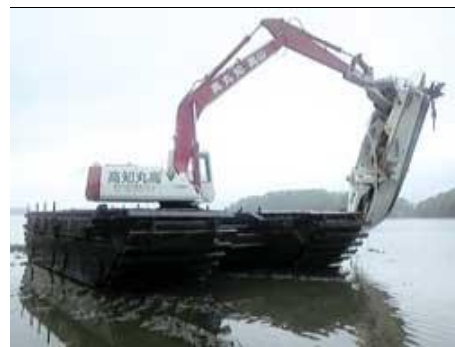
宮城県女川町での津波がれき撤去作業
