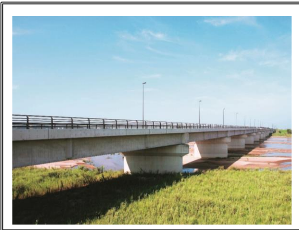
出雲バイパス新神立橋上部工工事
