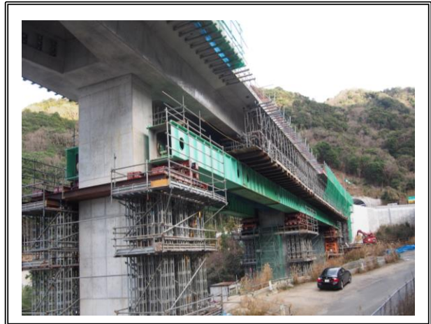
高松自動車道 大谷川橋(PC上部工)工事
