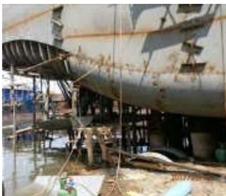
フィリピンにおける新造船船体の外板貼り付け作業
