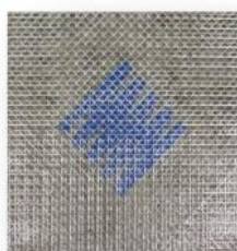
ガラス繊維シート設置
