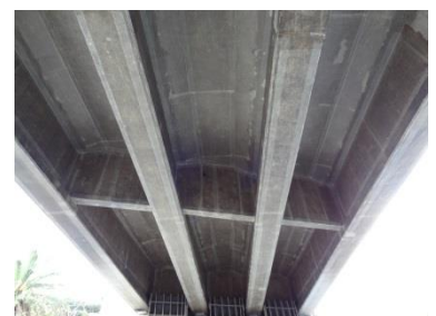
提案製品を施工した棕野大橋
