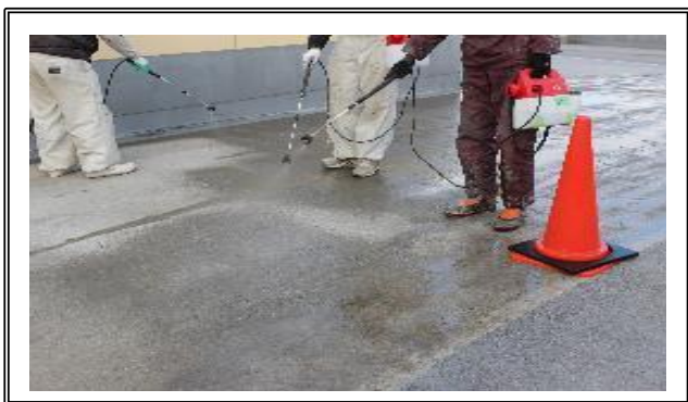
エバープロロング施工の様子
