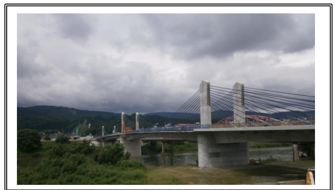
エバープロロング工法を用いて補修した橋脚
