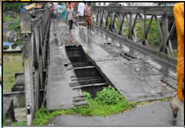
(改修すべき危険な橋)
