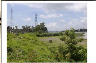
ハリプール発電所建設予定地
