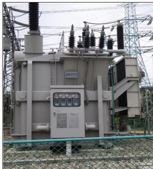
既設変電所の変圧器
