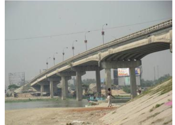
現カチプール橋
